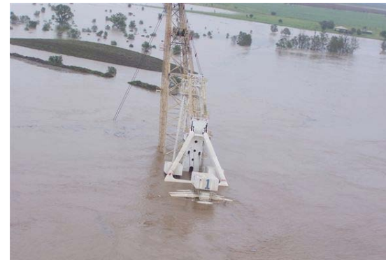
(写真: 豪州における炭鉱の洪水被害)
