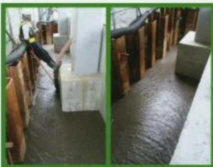
Case4 地下空洞への充填事例
