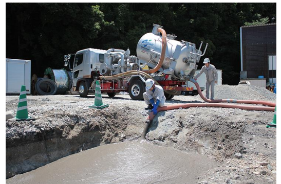
流動化土埋戻作業の風景
