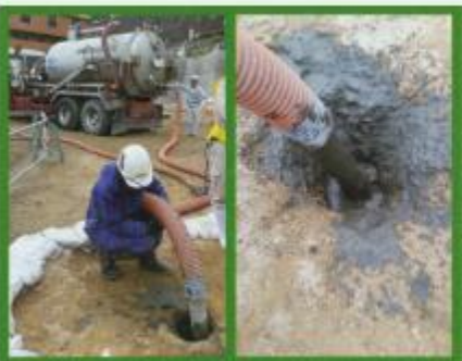
Case4 地下空洞への充填事例
