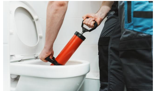
トイレのつまり修理
