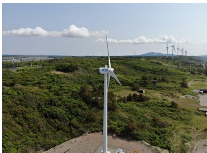
山鋼プラント秋田男鹿第1発電所
