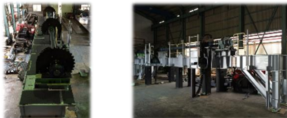
厚板工場 スラブ昇降装置 (韓国+本社)
